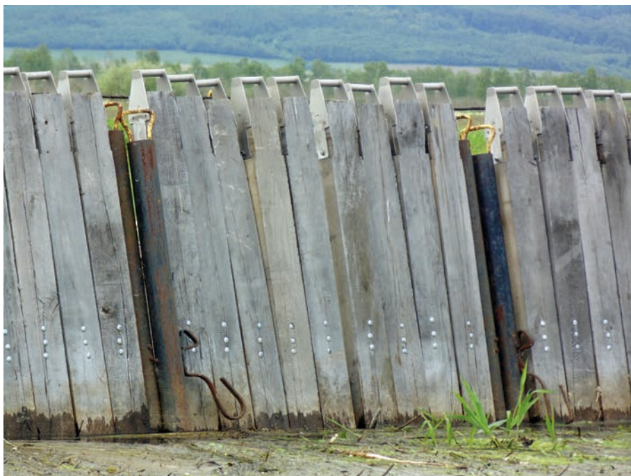
Fot. 19. Jaz iglicowy w na stopniu wodnym Krostkowo
