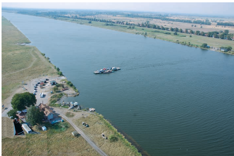
Fot. 4. Koryto Wisły w osi przeprawy promowej pomiędzy Świbnem a Mikoszewem (ok. 938 km) – odcinek Przekopu Wisły o długości 7 km
