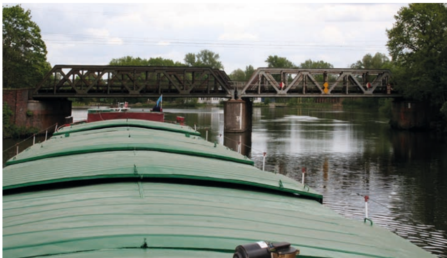
Fot. 41. Most kolejowy Bydgoszcz – Toruń na rzece Brdzie w Brdujściu
