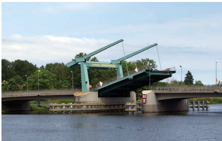
Ryc. 34. Most drogowy zwodzony w miejscowości Rybina w km 15+45 rzeki Szarpawy Źródło: G. Nadolny, czerwiec 2016
