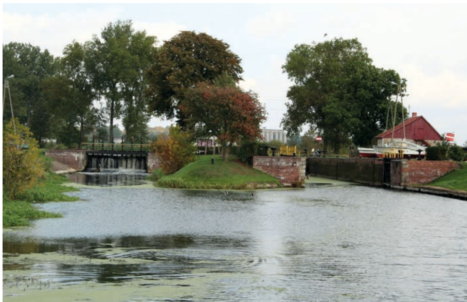
Fot. 20. Stopień wodny Nakło Zachód. Widok od strony dolnego stanowiska Źródło: D. Szatten
