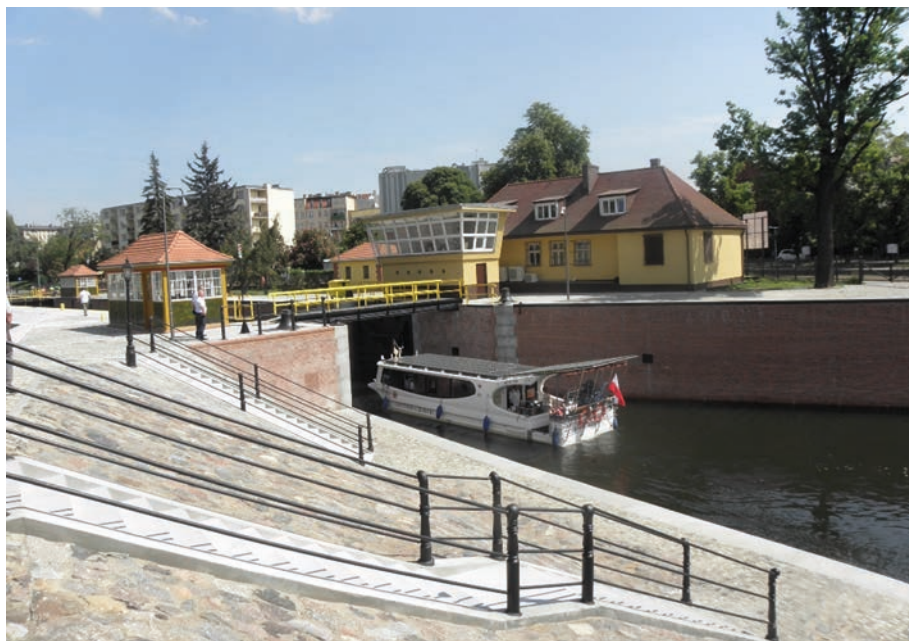
Fot. 28. Śluza miejska na Brdzie w Bydgoszczy. Widok od strony wody dolnej
