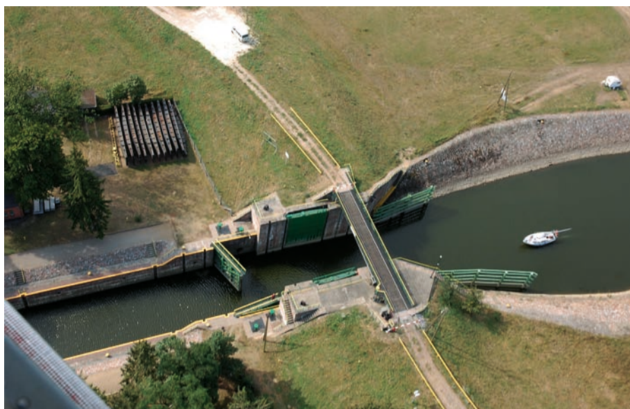
Fot. 35. Wejście od strony Wisły do komory śluzy Gdańska Głowa. Po prawej widoczny jest most obrotowy, pod nim wrota przeciwpowodziowe
