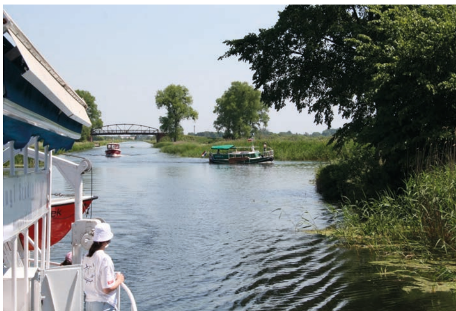
Fot. 21. Stanowisko szczytowe Kanału Bydgoskiego
