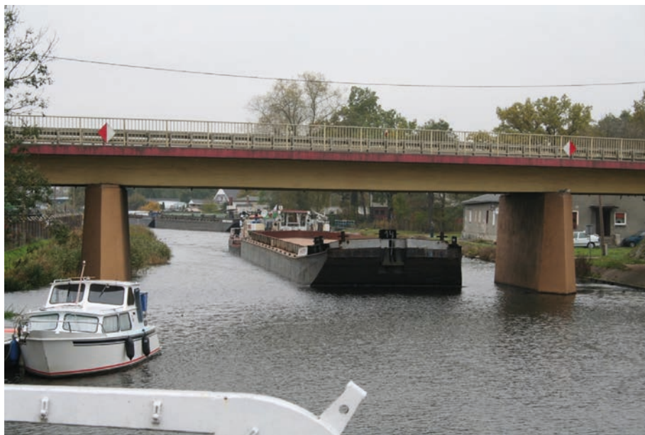
Fot. 38. Most drogowy na Noteci w Nakle. Przejście zestawu pchanego
