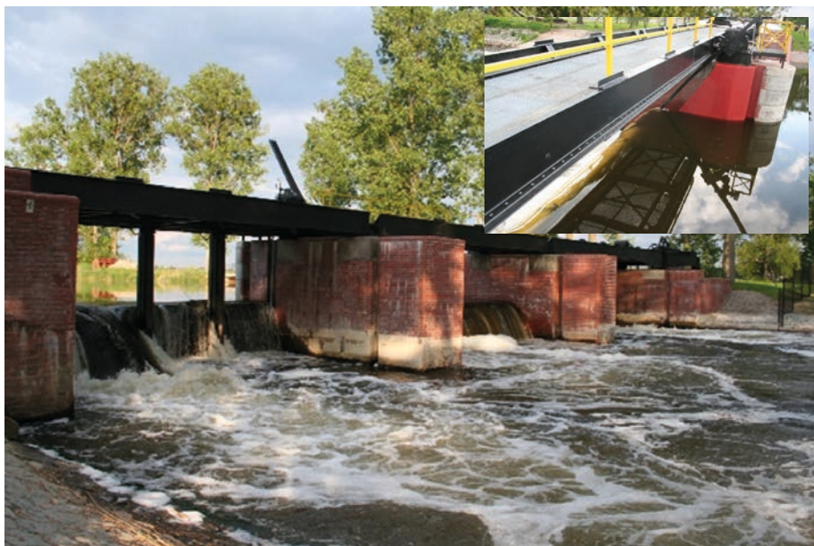
Fot. 12. Środkowe przesło jazu w Wieleniu z zastosowaną jedną klapą uchylną Źródło: G. Nadolny
