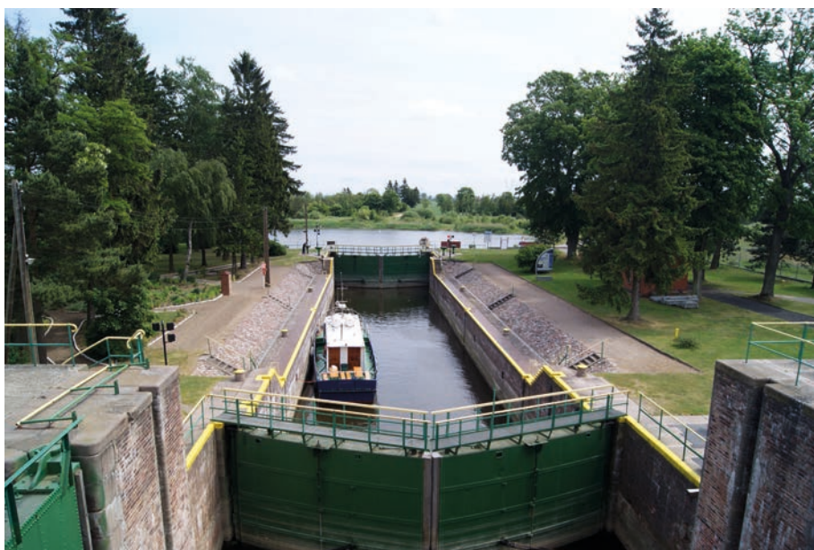
Fot. 33. Komora śluzy Gdańska Głowa, na wejściu z Wisły do Szkarpawy w 931 km Wisły. Widok od strony Wisły z mostka obrotowego nad wrotami przeciwpowodziowymi
