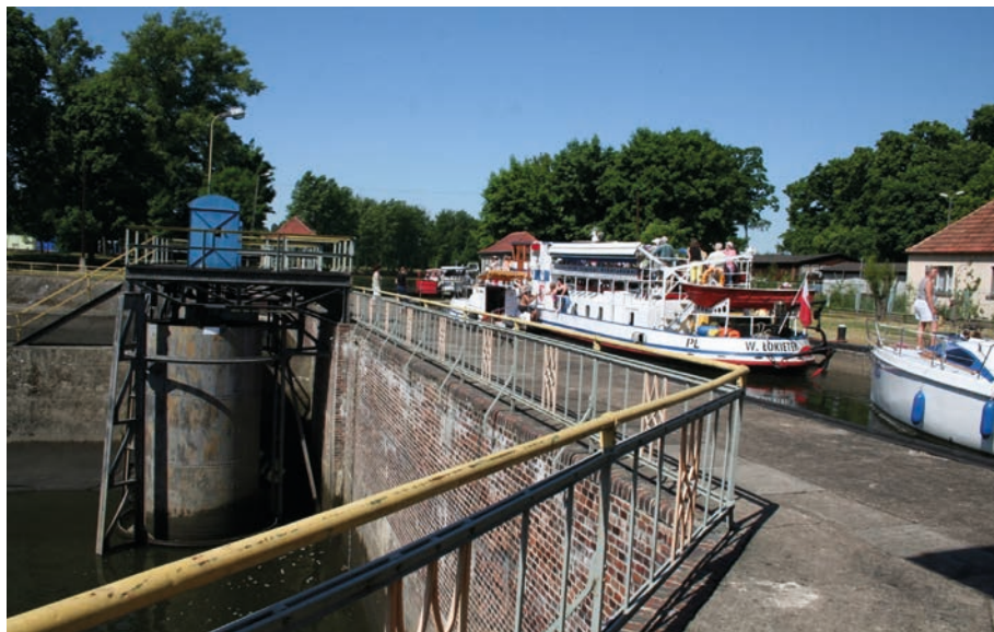
Fot. 25. Śluza Czyżkówko – widok na zbiornik oszczędnościowy i stanowisko górne Źródło: G. Nadolny
