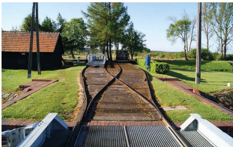
Fot. 17. Najazd do ustawiania wrót jazu na stopniu wodnym Nowe na Noteci Źródło: D. Szatten
