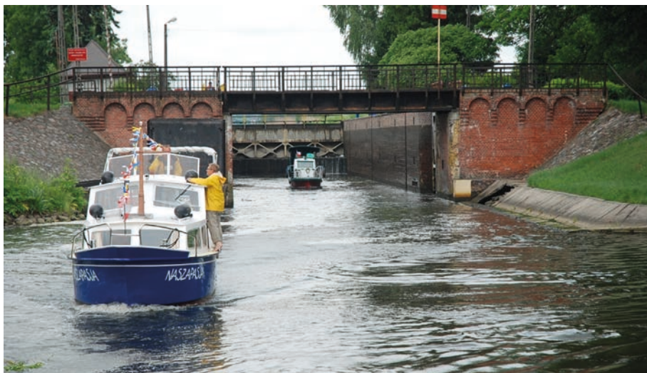
Fot. 23. Śluza Osowa Góra – stanowisko dolne
