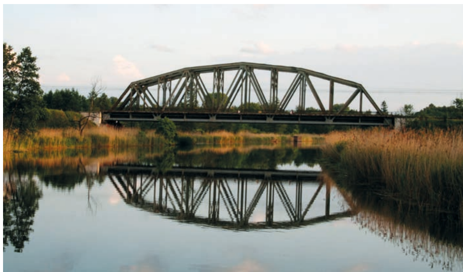
Fot. 39. Most kolejowy Poznań – Krzyż na Noteci
