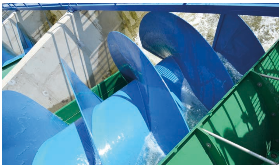
Fot. 14. Turbiny ślimakowe na elektrowni wodnej stopnia piętrzącego Rosko na Noteci
