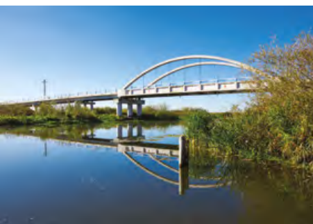
The bridge over the Noteć River in Białośliwie. Photo: P. Pasieczny
