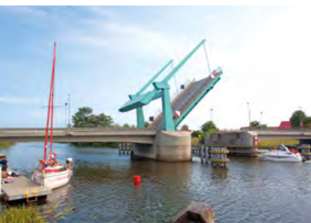
Bridge in Drownica. Photo: A. Wołosz
