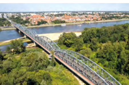
Józef Piłsudski Bridge. Photo: Berda.pl
