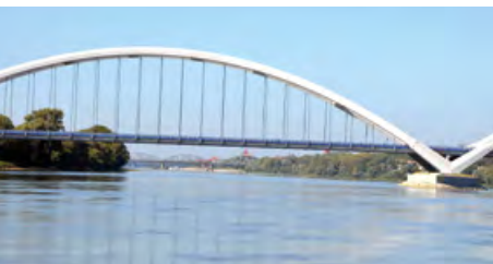
Elżbieta-Zawacka-Brücke. Fot. L. Turowski
