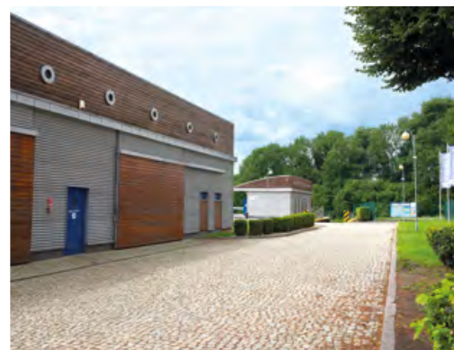
Infrastruktur des Jachthafens Czarnków. Fot. Berda.pl
