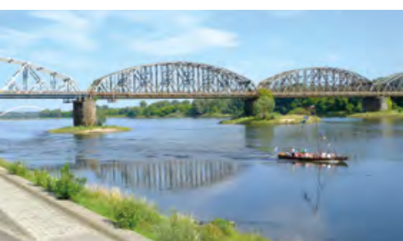
Ernest-Malinowski-Eisenbahnbrücke. Fot. Berda.pl
