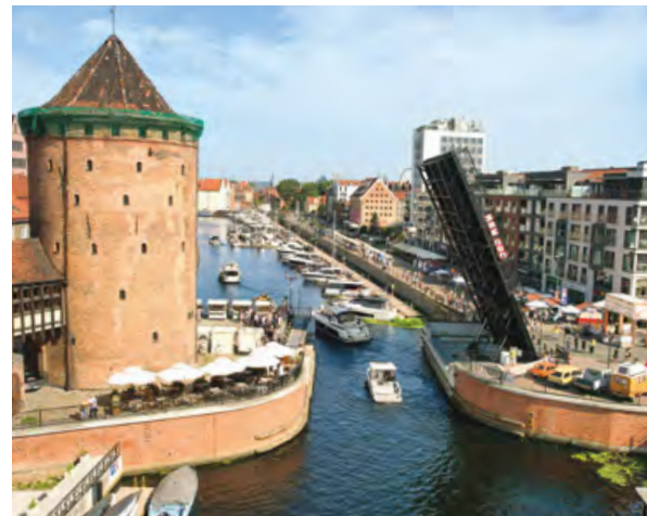
Stągiewny-Brücke. Fot. Berda.pl
