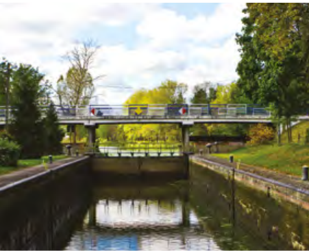
Schleuse Nr. 10 Gromadno. Fot. P. Pasieczny
