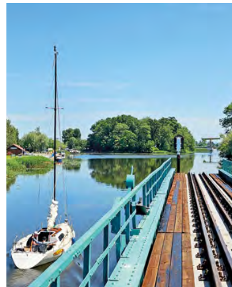
Blick von der Eisenbahnbrücke auf die Szarpawa Fot. R. Wasil
