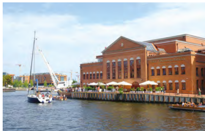
Fußgängerbrücke an der Baltischen Philharmonie.. Fot. Berda.pl
