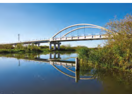
Brücke über die Netze in Białośliwie. Fot. P. Pasieczny
