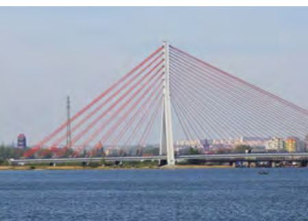
Schrägseilbrücke. Fot. R. Wasil
