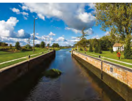
Schleuse Nr. 17 Mikołajewo
