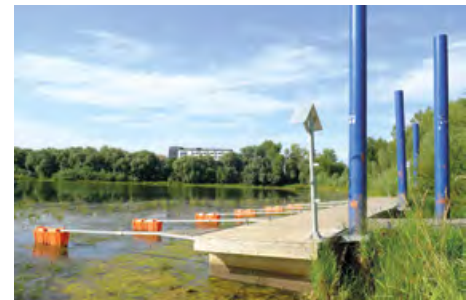
Port Drzewny (Holzhafen). Fot. Berda.pl
