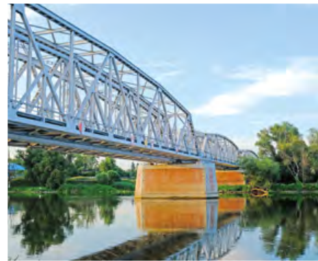
Eisenbahnbrücke in Kostrzyn nad Odrą Fot. Berda.pl
