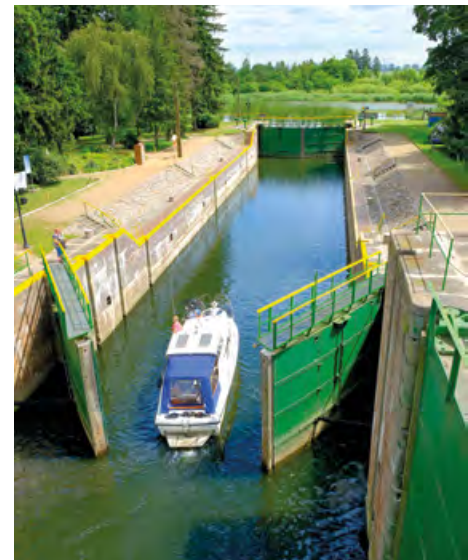
Schleuse, Gdańska Głowa. Fot. Berda.pl
