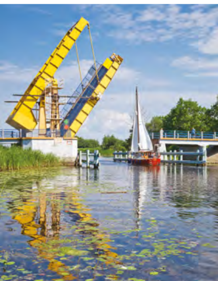
Klappbrücke in Rybina. Fot. P. Pasieczny
