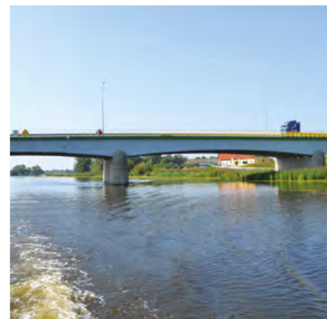
Brücke in Jazowa. Fot. H. Gonera
