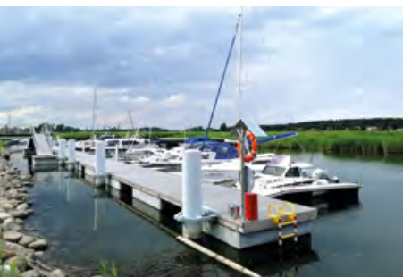
Wasserstation Wiślinka. Fot. R. Wasil
