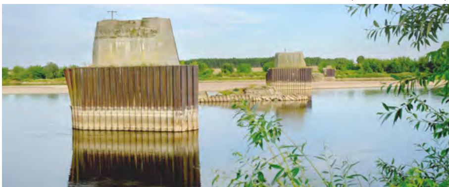
Pfeiler der Opalenie-Brücke. Fot. Berda.pl
