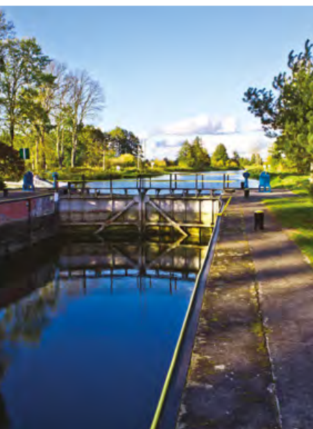
Schleuse Nr. 14 Romanowo. Fot. P. Pasieczny
