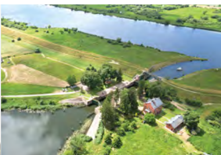
Schleuse Gdańska Głowa. Fot. Berda.pl
