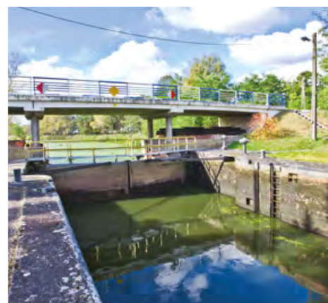
Schleuse Nr. 10 Gromadno. Fot. P. Pasieczny
