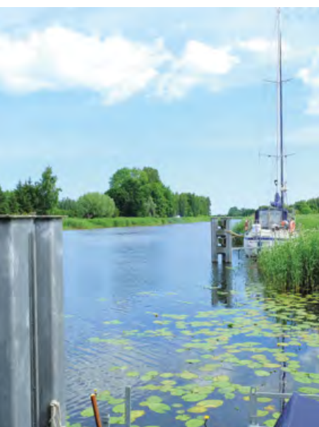
Leitdalben der Klappbrücke in Drewnica. Fot. Berda.pl
