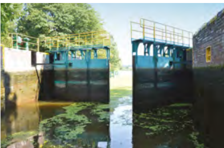
Schleuse Rakowiec. Fot. H. Goner
