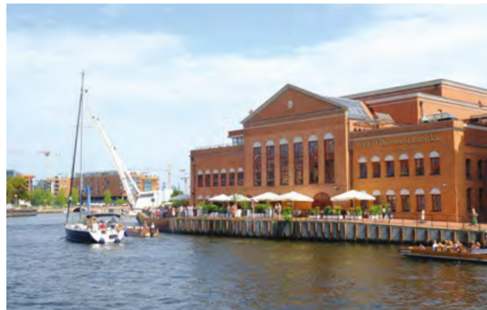
Kładka piesza przy Filharmonii Bałtycka. Fot. Berda.pl
