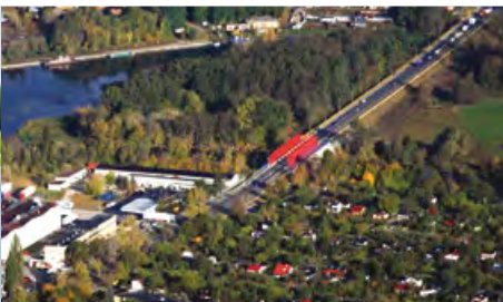
Most kolejowy magistrali węglowej. Fot. M. Szelest
