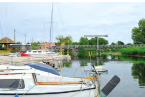
Most na rzece Pasłęka. Fot. Berda.pl
