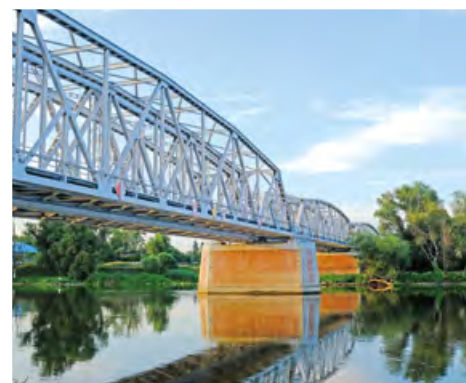
Most kolejowy w Kostrzynie nad Odrą Fot. Berda.pl
