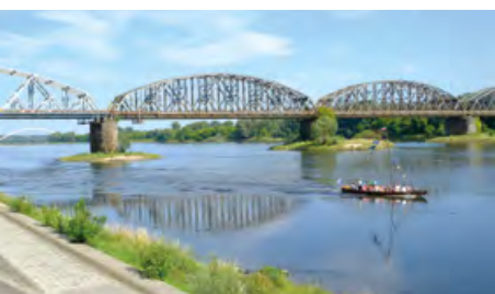
Most kolejowy im. Ernesta Malinowskiego. Fot. Berda.pl
